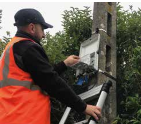
Installation d'une prise de raccordement à la fibre
