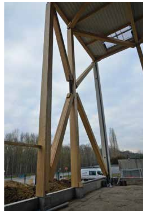
Structure en bois du bâtiment en construction
