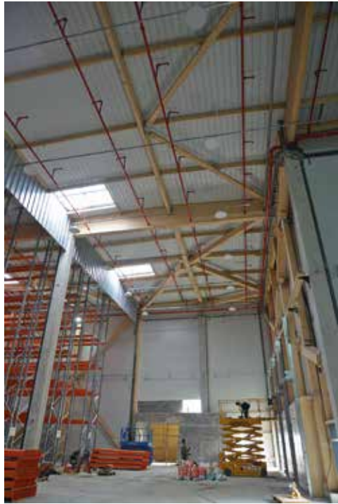
Intérieur du nouveau bâtiment en construction
