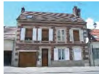
La période consacrée à l'édification de la typologie a permis son enrichissement, et c'est ainsi que les parements, traditionnellement construits en pierre de taille apparente ou en moellons enduits à la chaux, sont parfois remplacés par de la brique pour les parties courantes. L'accès au logis peut se faire par une ancienne porte charretière qui trouve aujourd'hui une autre fonction.
