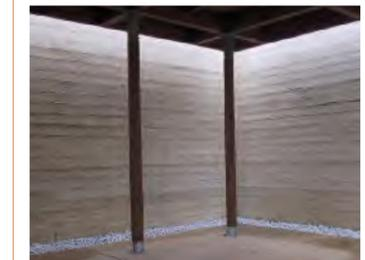
Abri composé de murs et sol en béton clair avec un fossé de gravillons qui reçoit les eaux de pluie provenant de l'ouverture entourant la toiture apportant un éclairage naturel
