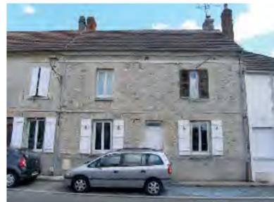
La tuile plate petit moule a été progressivement remplacée par la tuile mécanique, plus grossière, à partir de la fin du XIX<sup>e</sup>. Les moellons, soigneusement montés, sont recouverts traditionnellement d'un enduit à la chaux. La partition horizontale est marquée par deux fins bandeaux plats.
