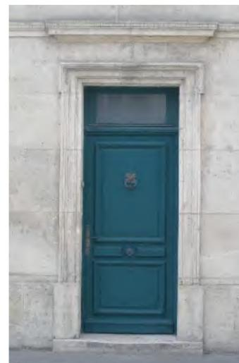
Les plus belles façades en pierre de la rue du Général de Gaulle possèdent des entrées décorées de chambranles avec socle sur marche massive et dessus de porte mouluré relié au bandeau intermédiaire.
