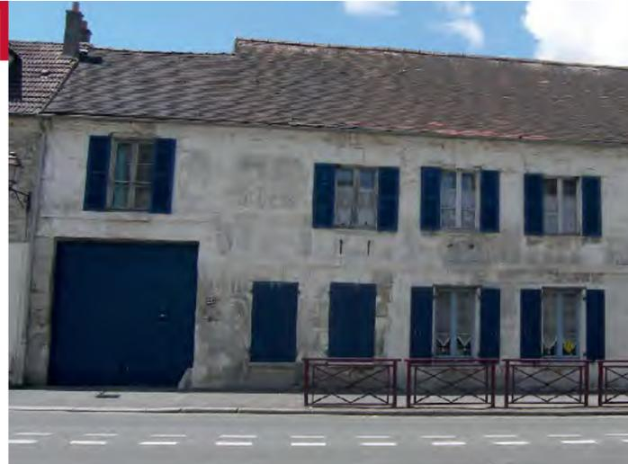
Les menuiseries sont généralement composées de deux vantaux ouvrant à la française (vers l'intérieur de l'habitation), eux-mêmes divisés, traditionnellement en trois ou quatre carreaux. Les menuiseries les plus anciennes sont à petits carreaux. L'ouvrage de menuiserie est différent suivant la typologie et l'époque de construction.
