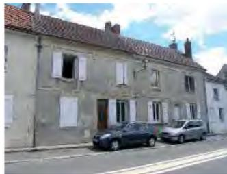
La construction forme un parallépipède rectangle sur un ou deux niveaux, avec des façades généralement composées. Elle est coiffée d'un toit à deux versants, généralement entre 30 et 40° dont le faitage est strictement parallèle à la rue. Elle est toujours bâtie à l'alignement.
