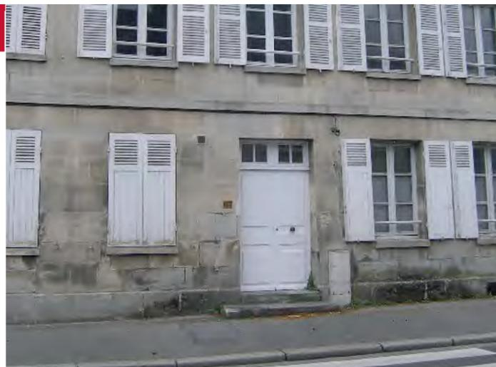
Les portes d'entrée des maisons sont des ouvrages en bois plein, à un vantail ou tiercé, souvent surmontés d'impostes vitrées permettant d'éclairer le couloir de l'immeuble.
