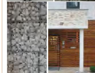
Matériaux : résilles métalliques pour plantes grimpantes, mur en gabion (caisson en treillage métal rempli de caillasse), mur en moellon enduit à pierre vue et clinis de bois associés aux fenêtres cadrées
