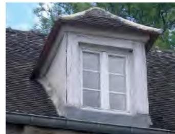
Les lucarnes sont en maçonnerie ou charpentées. Elles sont protégées par des enduits sur les jouées ou des couvertures de terre cuite ou en ardoise. Du zinc complète les protections.
