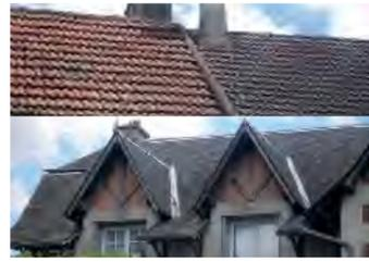
Les couvertures traditionnelles sont en tuile plate petit moule (60 à 80 au m<sup>2</sup>). La tuile plate plus moderne ou la tuile mécanique est venue renouveler les versants dès le milieu du 20<sup>e</sup> siècle, ou en ardoises avec le développement des toitures à la «Mansart» sur les maisons XIX<sup>e</sup>-XX<sup>e</sup>.
