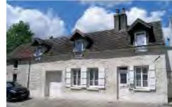
Les façades sont ordonnancées ou bénéficient d'une composition aléatoire. Les fenêtres sont plus hautes que larges et les linteaux ne sont pas forcément alignés. Le comble sert de stockage, alimenté par une ancienne baie à engranger dite feunière engagée dans la maçonnerie sous l'égout. Des lucarnes sont venues éclairer les combles après-coup.
