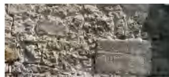
Les structures moellonnées enduites à l'origine, laissent apparaître parfois des surfaces brutes avec des anciens mortiers de hourdage à la terre argileuse, puis tardivement à la chaux.
