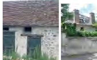
Les façades et les murs de clôtures succèdent le long des rues du village. La rue principale affiche des appareils de pierre, tandis que les rues adjacentes des structure en moellons. Dans ce cas, l'enduit plus ou moins couvrant à la chaux naturelle est de finition lissée. Les anciens enduits ont été souvent remplacés par des enduits hydrauliques (ciment) voire des enduits monocouches ou tyroliens.
