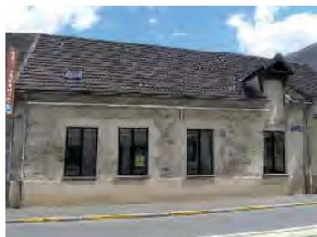
Parfois, les façades profitent d'éléments en appareil de pierre de taille renforçant les parties fragiles comme les encadrements de baie, les appuis, les linteaux, puis les soubassements ou les corniches.
