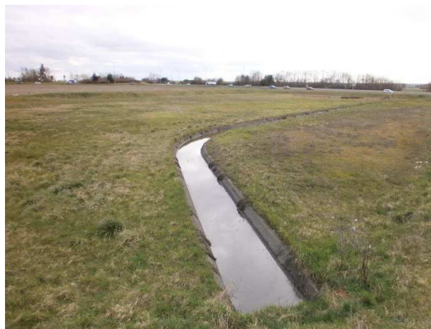
Bassin de rétention avec étanchéité par argile compactée + engazonnement
