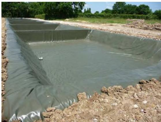
Bassin de rétention avec étanchéité par géomembrane
