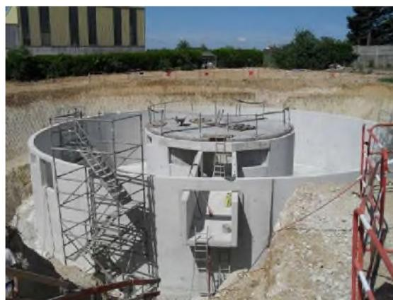
Bassin de rétention en béton armé
